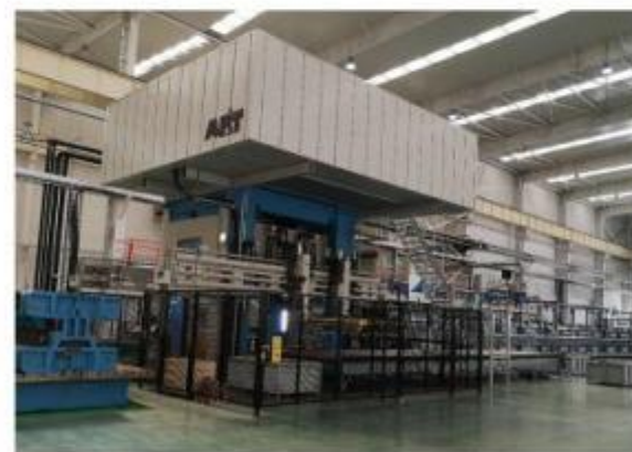
万华汽配公司 (热成型冲压线)
