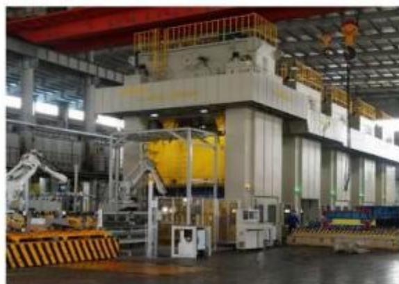
沪荣汽配公司 (机器人冲压线)
